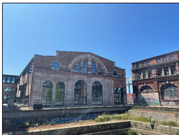
Bevarede værkstedsbygninger omkring den gamle tørdok
